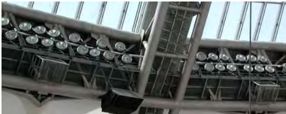
링트러스에 설치된 경기장 조명등
