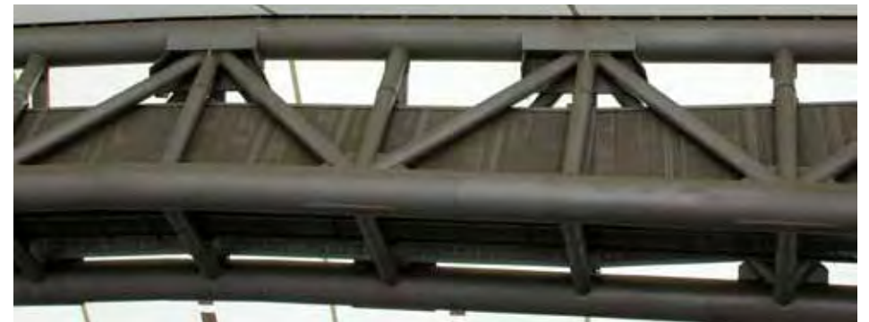
소리의 난반사를 막기 위하여 방사형 트러스에 설치된 흡음재
