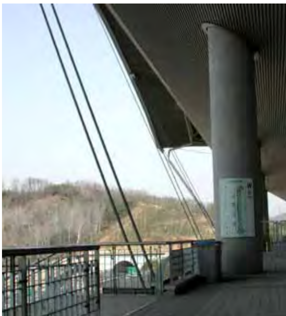
외곽트러스를 아래로 당겨주는 강철케이블
