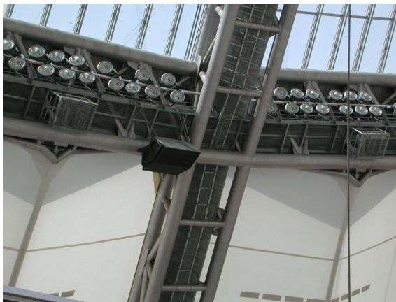
링트러스에 설치된 경기장 조명등
