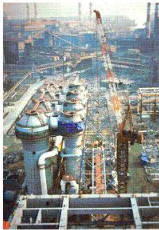
광양제철의 고로 설치작업 24)
